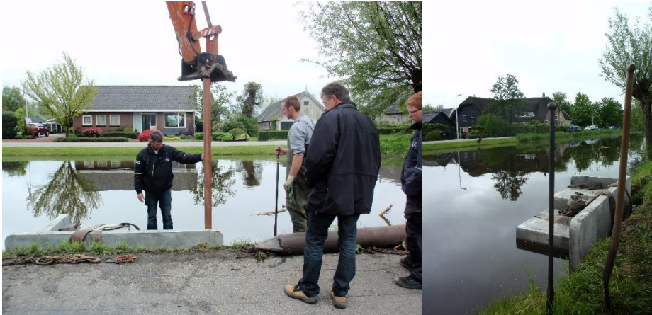
Het restaureren en terugplaatsen van een boenstoep gebeurt op professionele manier.
